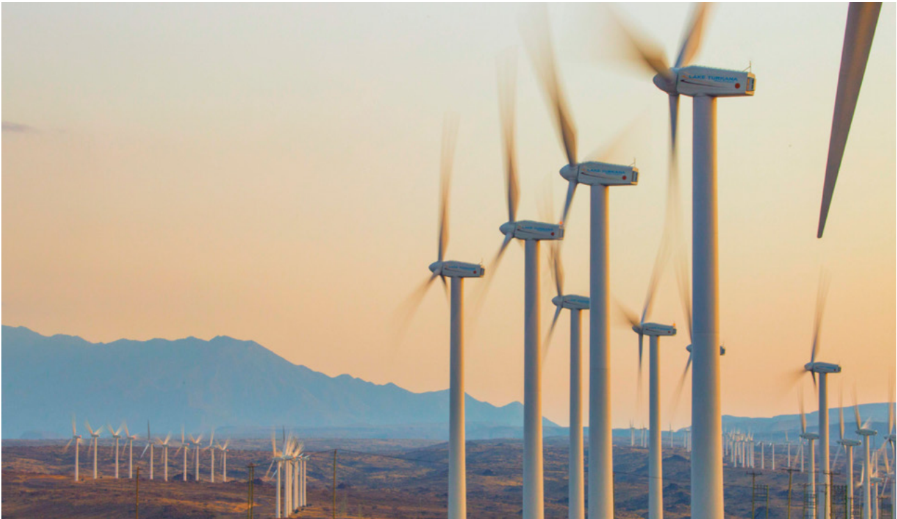
Syksyllä 2018 Kenian sähköverkkoon kytkettiin Afrikan suurin tuulipuisto Lake Turkana WInd Power. Finnfund on ollut hankkeen osakkaana rakentamisen alkuvaiheesta lähtien eli vuodesta 2013.
